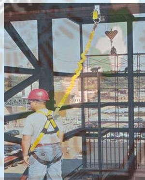
Gambar 2.3 penempatan lanyard pada anchorage point<sup>(16)</sup>
