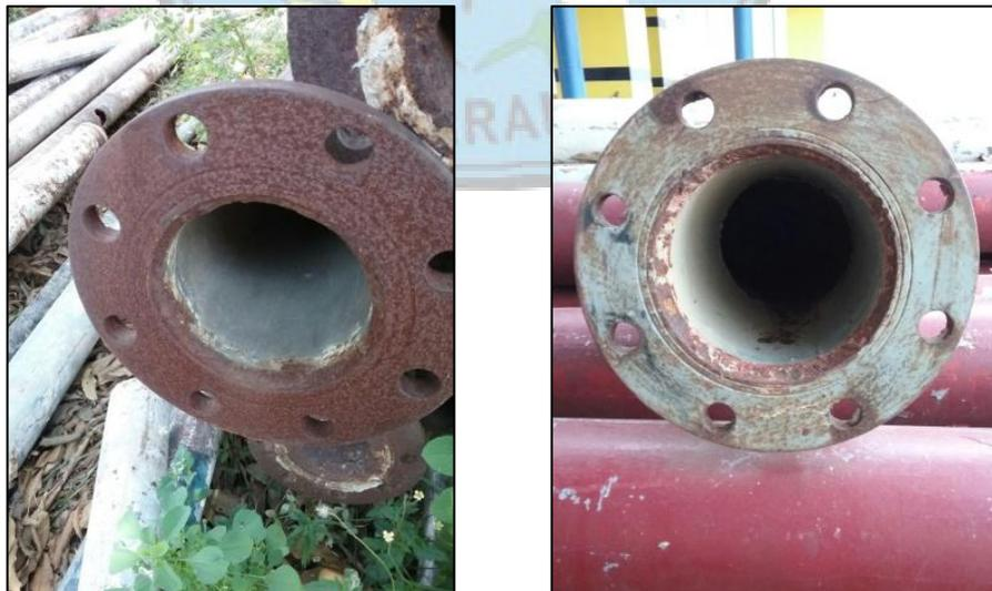
Gambar 2.1 Endapan kerak kalsium Sulfat dalam Pipa
