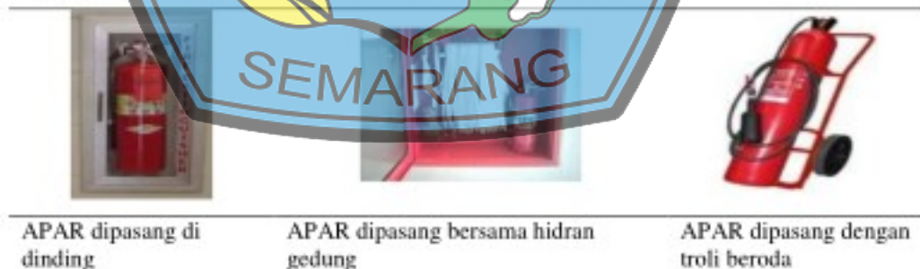
Gambar 2.1 Pemasangan APAR 9 .
