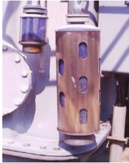
Gambar 18. Konstruksi Alat Pernapasan Transformator
