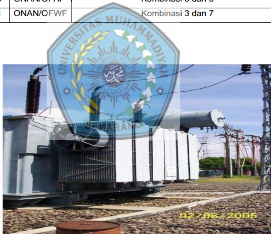
Gambar 13. Pendingin Trafo Type ONAF
