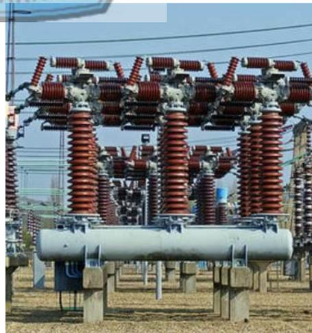
Gambar 2.7 PMT Udara Hembus (*Air Blast*)
