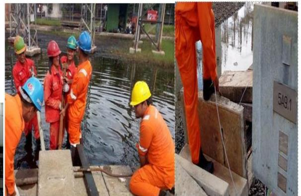
Gambar Proses Pembukaan Duck Kabel dan Penarikan Kabel UTP / LAN
