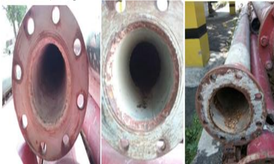
Gambar 2.1. Sistem pipa pada mesin boiler pembangkit listrik untuk memindahkan panas dari satu fluida ke fluida lain (S. Raharjo, 2016)
