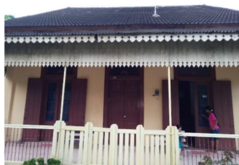
Gambar 3. Tampak Bangunan Rumah Tinggal
