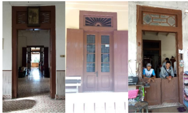
Gambar 7. Ornamen pada Pintu dan Jendela
